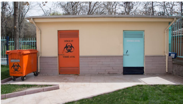
Şekil 13.7: Geçici atık deposu
