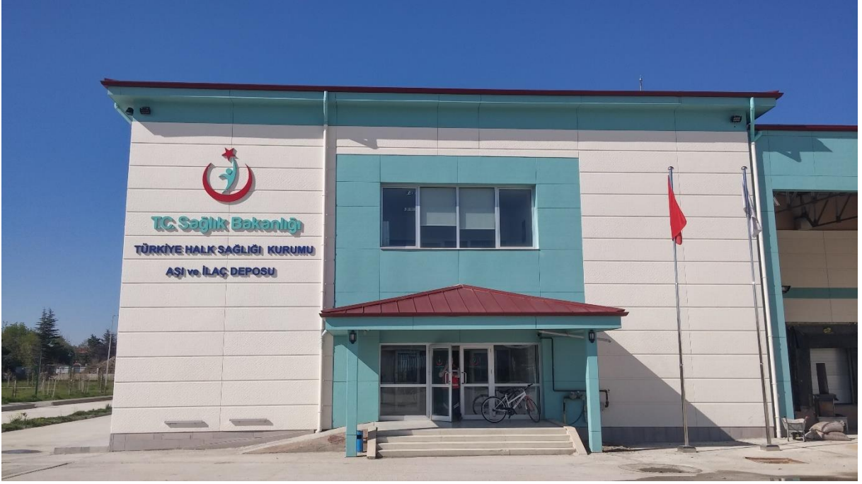
ŞEKİL 10.2- Çağrı Merkezinin bulunduğu Merkez Depo'nun dıştan görünümü
